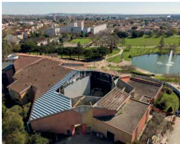
Odysud en travaux - mars 2026 © Fabien Ferrer
